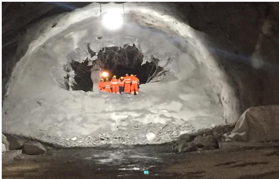
Foto Apertura della galleria "Paniga"
